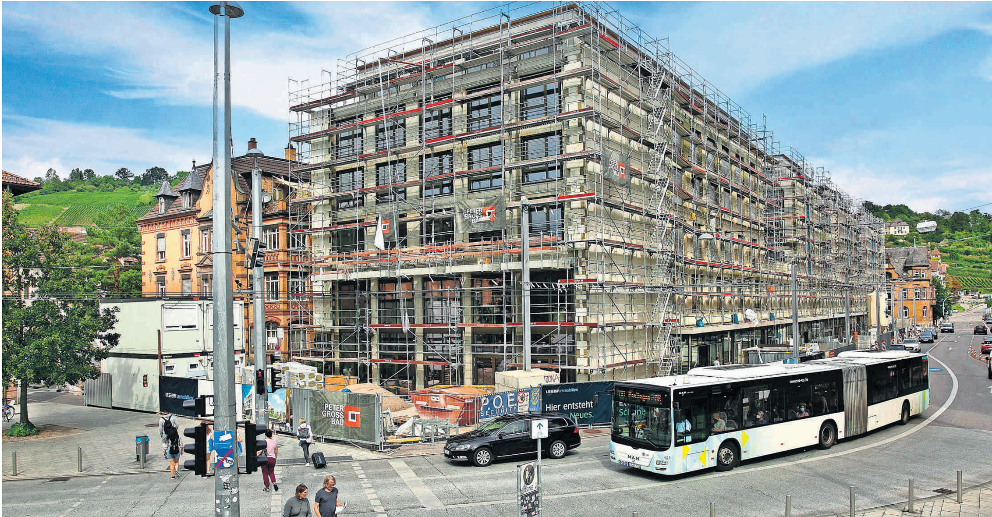
Weiterer Ankermieter für den Neubau auf dem alten ZOB: Ein Reha-Zentrum aus der ZAR-Familie wird mehrere Etagen im QBUS belegen.
